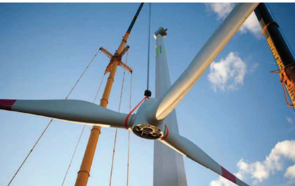
Die Errichtung der Timbertower-Anlage nahe Hannover
