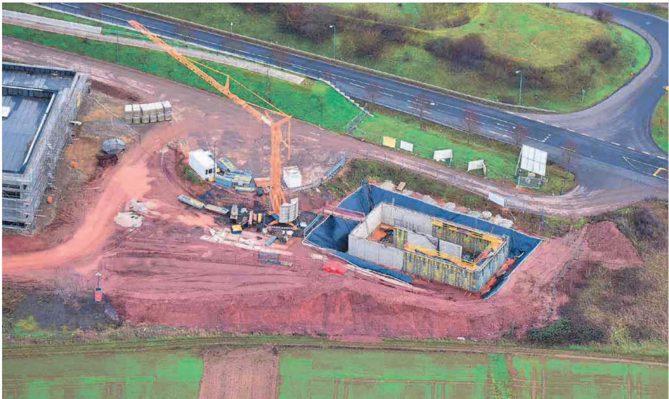
Schulbau in Schweich mit Vorbildcharakter – hier soll später mit einem Eisspeicher geheizt werden.
